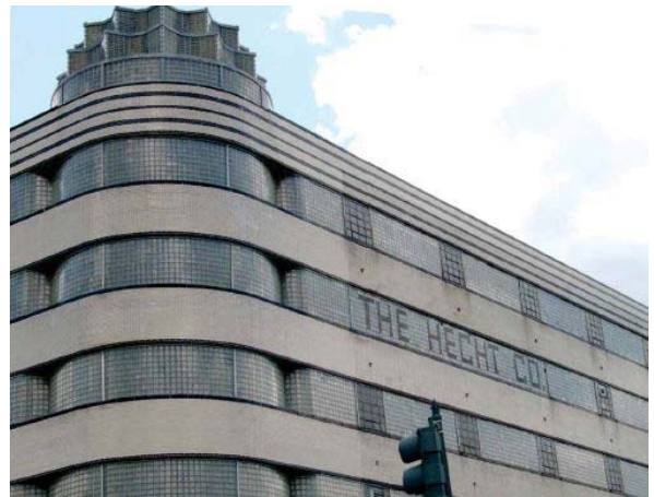
Hecht Warehouse, Washington, DC.
